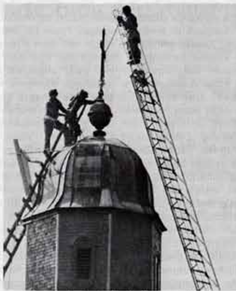
Das erneuerte Kreuz wird auf das Kollegiumstürmchen aufgesetzt
